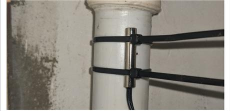
5. Нанесите термопасту из шприца для плотного прилегания датчика к трубе
