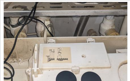
2. Отключите котел от сети и подключите провод из комплекта к клеммам внешнего термостата котла
